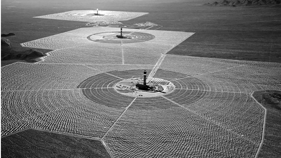
Солнечная электростанция в Калифорнии
